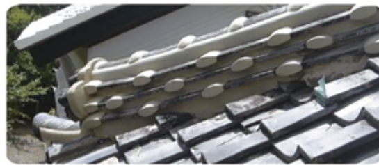
岩崎弥太郎生家の屋根施工
