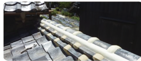
土居廓中での施工実績
